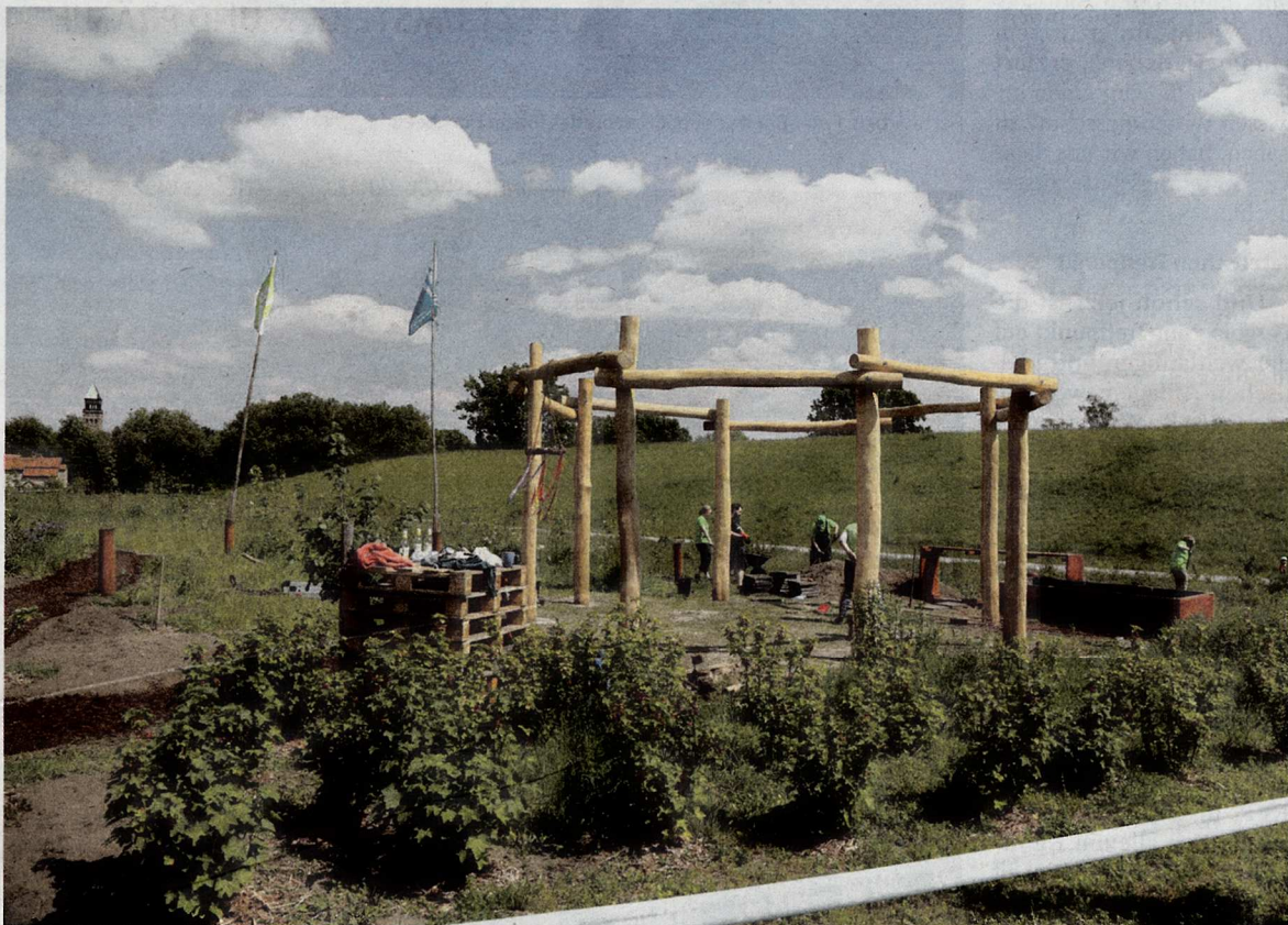
Die neue Pergola im Biomassepark ist ein Klassenzimmer mitten in einer grünen Oase.
